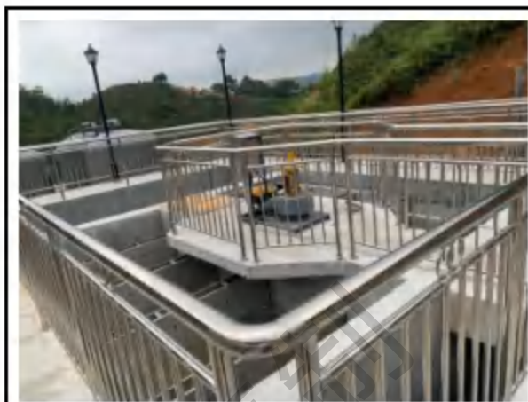
二级反应沉淀池-慢速混凝区
