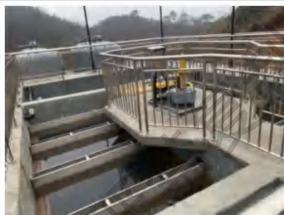
二级反应沉淀池-慢速混凝区
